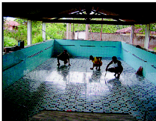
Una delle fasi della ristrutturazione della vecchia piscina
