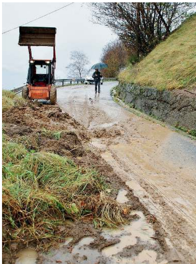
Danni provocati dal maltempo sulle strade della provincia
